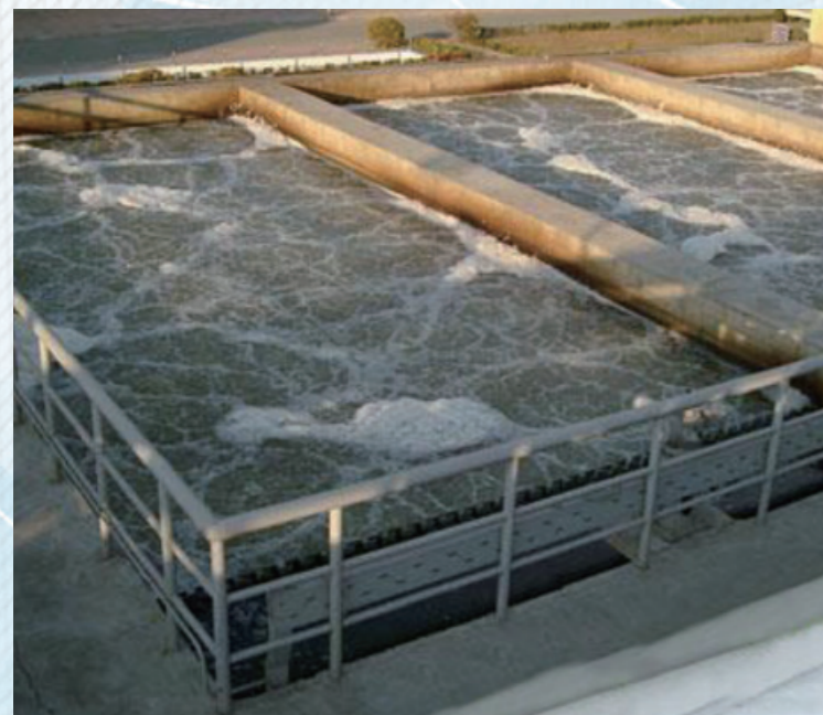
化工污水处理
