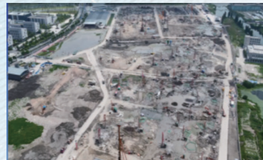
打桩污泥处理
